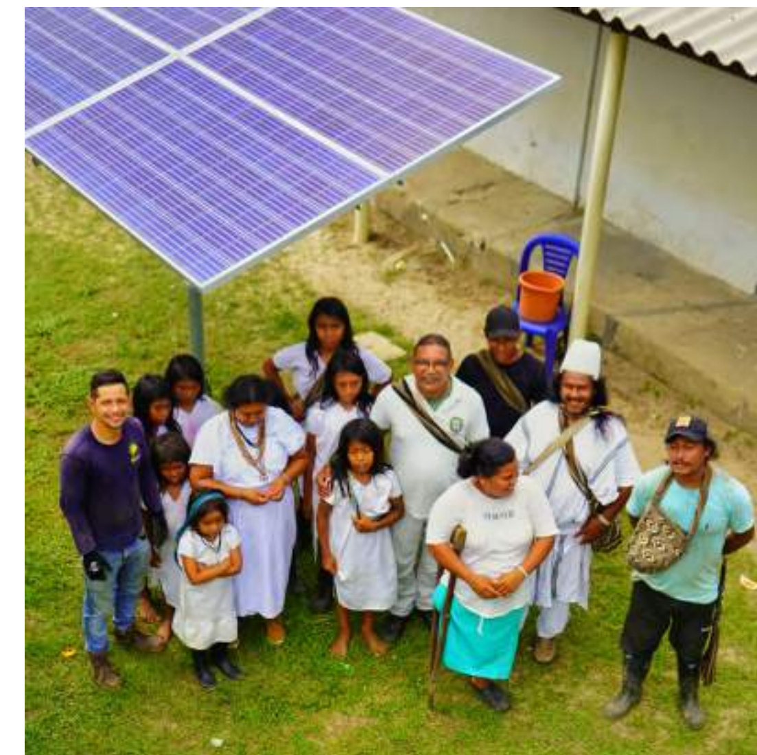
Instalación de paneles solares en Katanzama.
