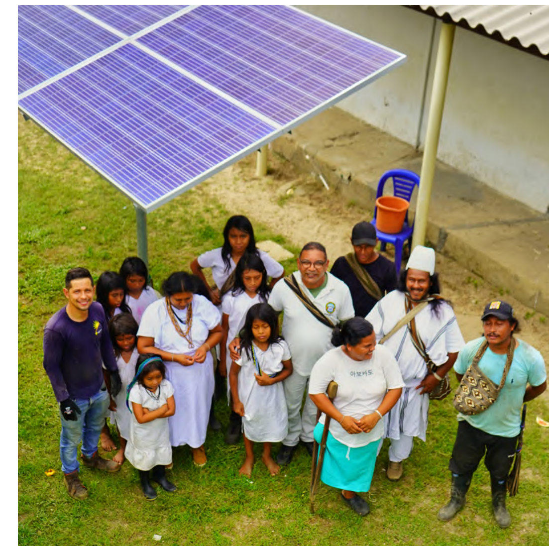
Instalación de paneles solares en Katanzama.
