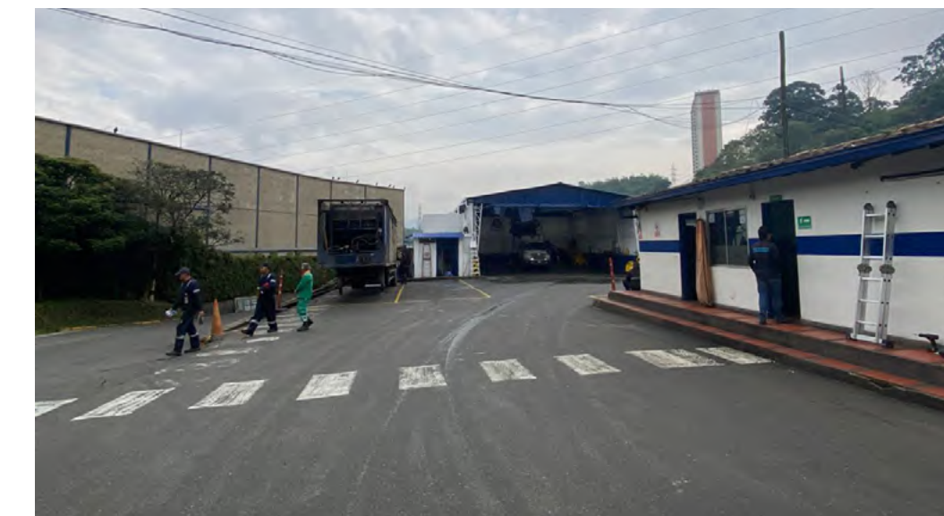
Instalaciones Estación de Transferencia ubicada en el municipio de Sabaneta, Antioquia
