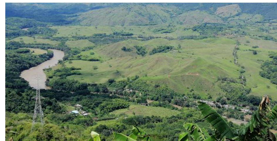
Vista panorámica del proyecto Refuerzo Suroccidental, tramo 1. Filadelfia, Caldas. Febrero 2024.
